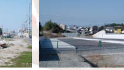
道路改良事業:飯塚大野城線(通称那珂川宇美線) 大野城市域のバイパス工事約2.4km 平成29年度完成を目指しています。
